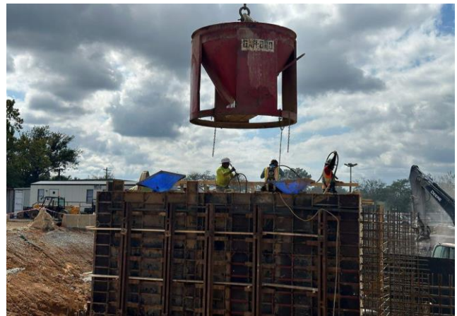
CMF Basin Wall Pour
