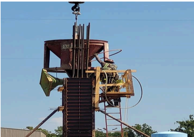
Bridge Crane Column Pour
